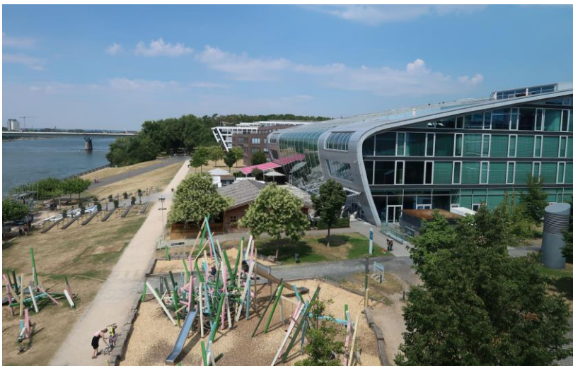
Umweltschonend Kälte im Sommer und Wärme im Winter: Dafür sorgt bei einem Hotel und zwei Bürogebäuden am „Bonner Bogen“ ein unterirdischer Aquiferspeicher (Foto: Paul Fleuchhaus, KIT).
