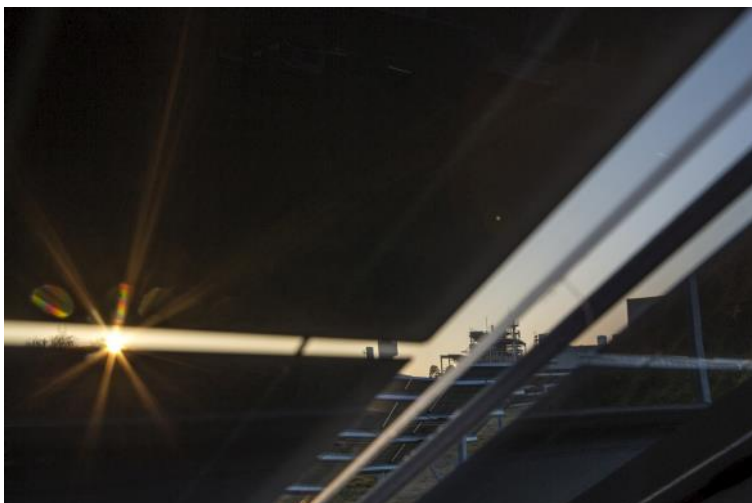
Technologien wie der Solarspeicherpark (Vordergrund) und die Biomasse-Pilotanlage bioliq (Hintergrund) werden am KIT entwickelt. (Bild KIT)
